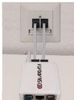
AM SMI Anschluss können jede Art von Medienkonvertern oder Switches verwendet werden.
