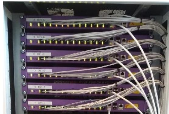
In diesem Netzwerkschrank sind mehrere POF 12+4 Port Switches untereinander verbunden und bieten jede Menge Zugangsmöglichkeiten in den einzelnen Hotelräumen.
